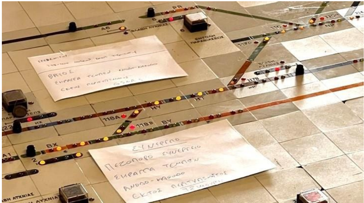
Εικόνα 48. Λεπτομέρεια του Πίνακα Ελέγχου Λάρισας με διαδρομή ρυθμισμένη για τη διέλευση ενός διακόπτη σε θέση παράκαμψης.
